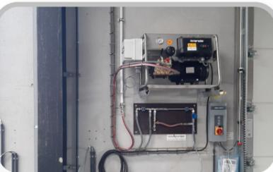
**SUPPORT MURAL** en acier galvanisé avec 4 silentblocs anti-vibrations
